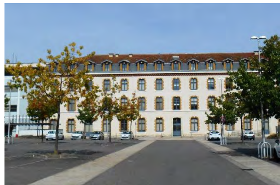
Immeuble de la MSA du Gers
